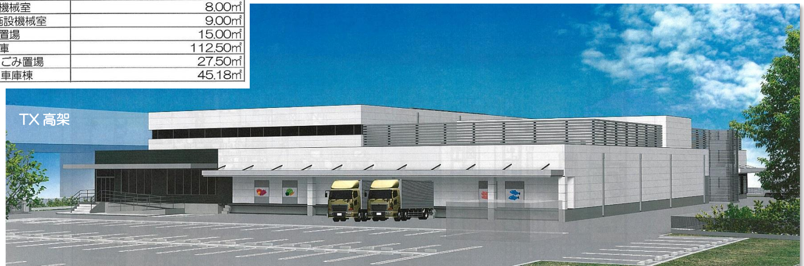
住宅地・県道側から
