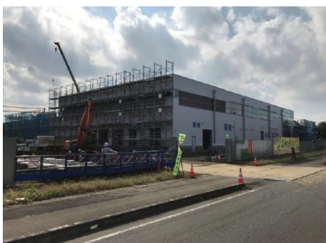
工事の様子（北東面）
