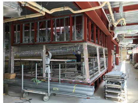
工事の様子（見学通路）
