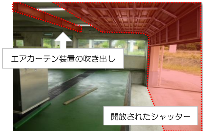
写真4：洗浄エリアの外部シャッター開放時
