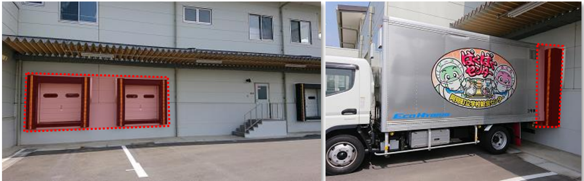
写真6：近年建設の給食センター配送車積み下ろし口
