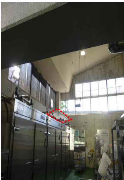
写真 6-3：熱風保管庫上部の覆い（波板製）
