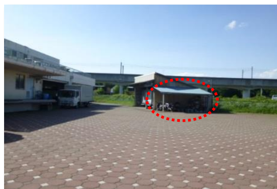
写真 6-5：屋外の運転手待機場所（屋根のみ）
