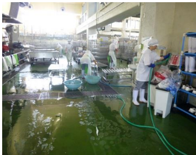
写真 6-7：下地処理室の床面
