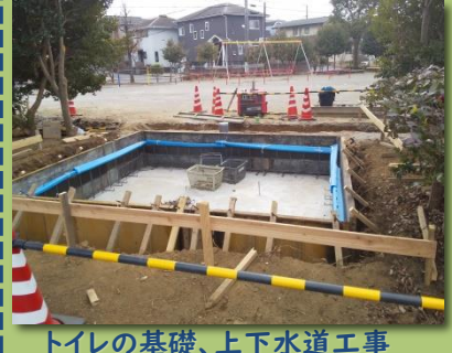
トイレの基礎、上下水道工事
