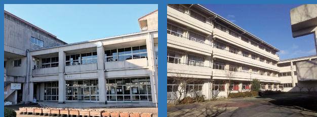
■御所ヶ丘中学校校舎校舎 (現状)
