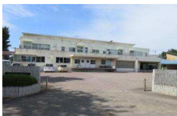
No. 6 学校給食センター
