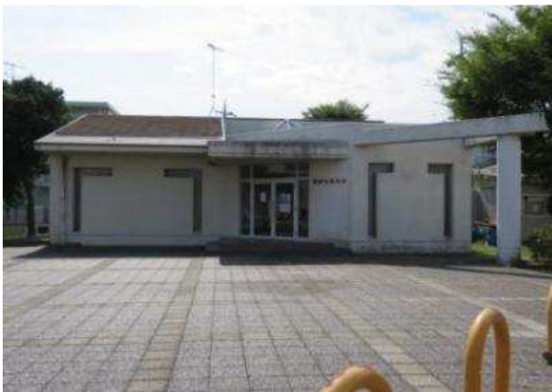
No. 3 5 市営住宅集会所
