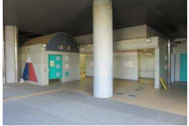
No. 6 2 公衆用トイレ（守谷駅西口）
