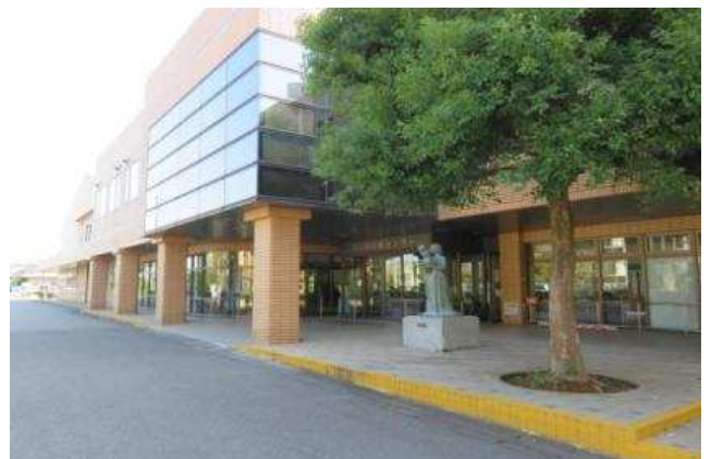
No. 5 4 保健センター
