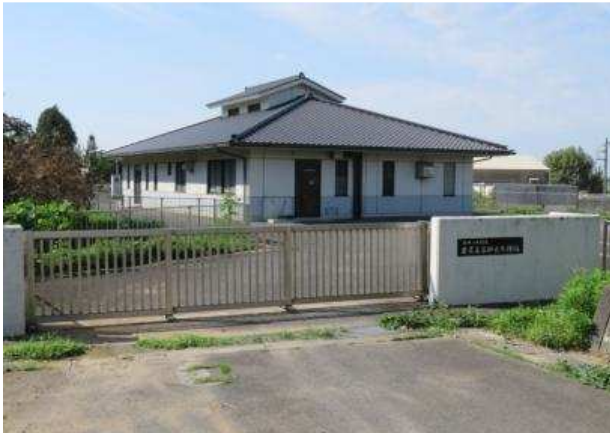
No. 6 3 農業集落排水処理場
