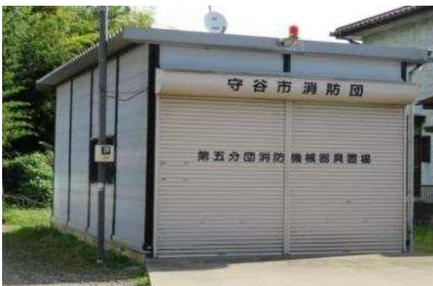
No. 2 1 消防団機械器具置場 (No. 1 7 ~ No. 2 0 及び No. 2 2 ~ No. 2 9 省略)
