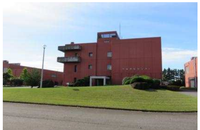
守谷市浄化センター
