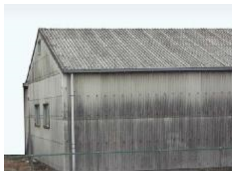
石綿含有スレート波板（屋根・外壁）
