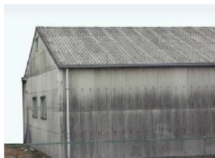
石綿含有スレート波板（屋根・外壁）
