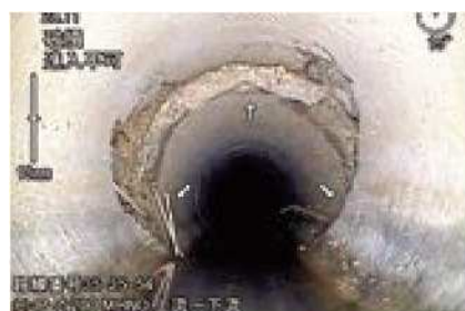
マンホールの隆起や管路内の損傷
