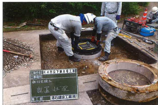
人孔鉄蓋更新工事
