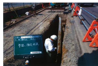
汚水管撤去状況
