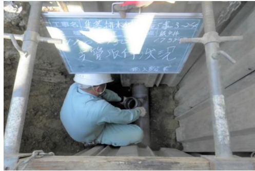
汚水樹設置工事
