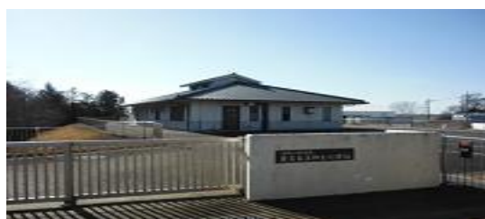
西板戸井地区 農業集落排水処理場
