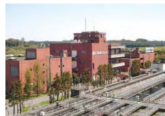
守谷浄化センター
