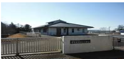
西板戸井地区 農業集落排水処理場
