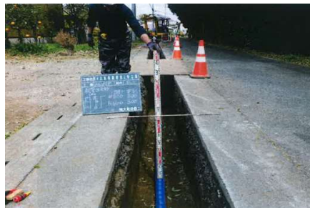
配水管布設替工事
