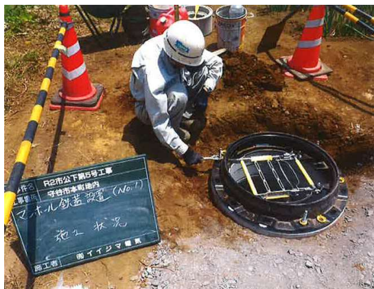
鉄蓋交換工事
