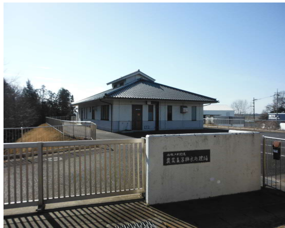
西板戸井地区 農業集落排水処理場
