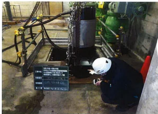
汚水ポンプ更新整備
