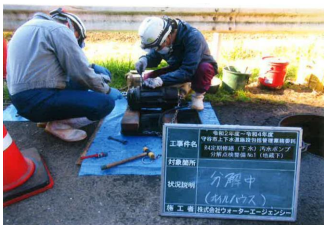
汚水ポンプ分解整備
