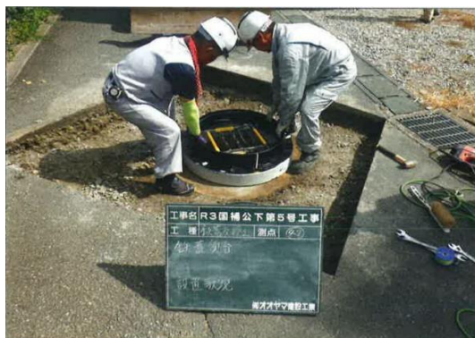
鉄蓋交換工事
