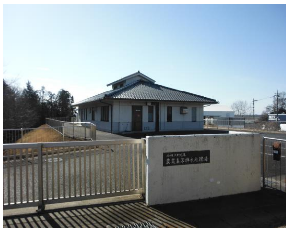
西板戸井地区 農業集落排水処理場
