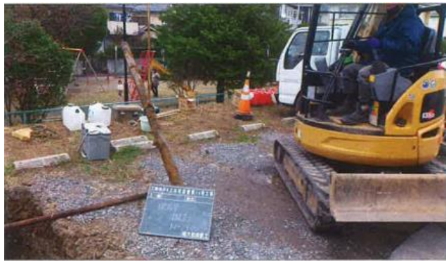
老朽管撤去状況
