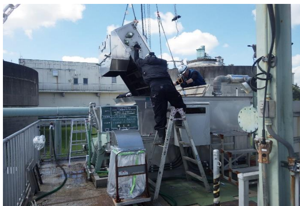
浄化センター定期修繕工事
