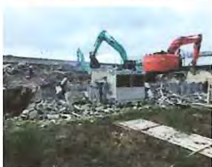
旧給食センター解体工事
