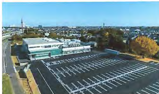
完成した駐車場
