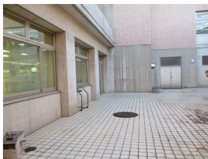
▲機械室前の空間
