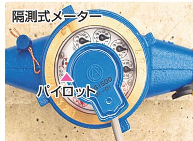
3 のメーターの写真で矢印の先にある銀色の羽根車がパイロットです。メーターの中を水が通るとパイロットが回る（右回り）仕組みになっています。宅地内の蛇口を全て閉めた状態でパイロットが回る場合は、宅地内のどこかで漏水していると判断できます。（パイロットの動き方が分かりにくいときは、蛇口を開けた状態で確認してみてください。）
