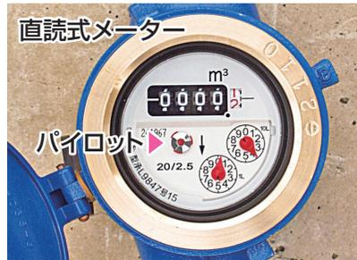
3 蛇口を全て閉めているのにパイロットが回る場合は漏水の可能性あります。（微量の漏水ではパイロットが1周するのに1～2分程度かかることがあります。）
