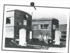
代燃発生炉を取り付けた機関車：戦時中(『常総鉄道株式会社30年史』から)
