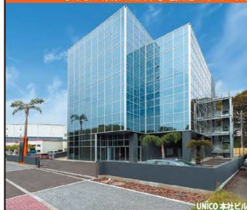
UNICO 本社ビル
