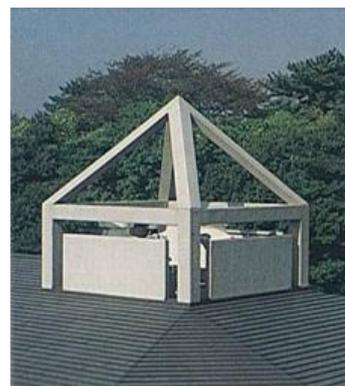
屋根の一部として目隠しにデザインを加え、その中に屋上に設置する設備類を隠している。
