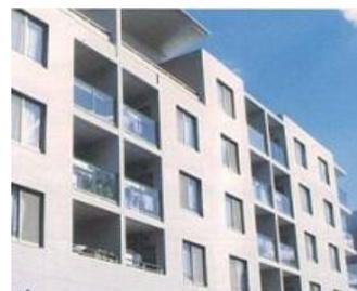
物干し台を低くするとともに、手すりに腰壁や半透明のパネルなどを用いて、洗濯物が隠れるように工夫した例。
