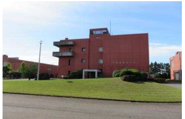
守谷市浄化センター
