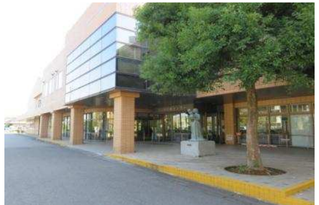
No. 5 4 保健センター
