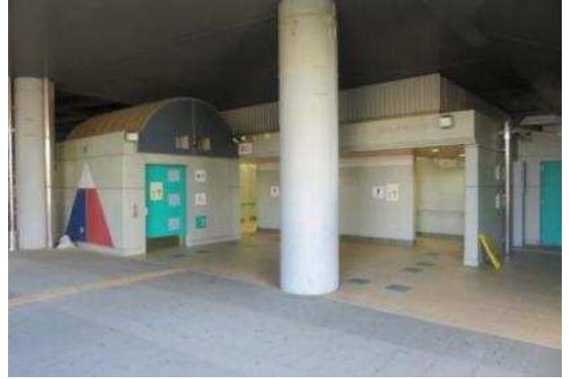
No. 6 2 公衆用トイレ（守谷駅西口）
