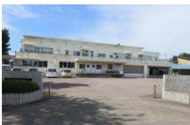
No. 6 学校給食センター
