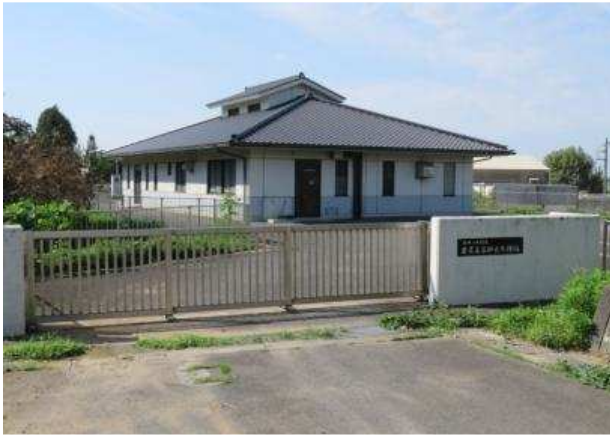
No. 6 3 農業集落排水処理場
