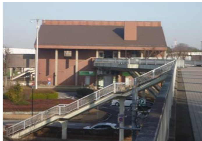
新守谷駅の外観
