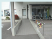
出入口の段差解消 事業費：30万円程度
