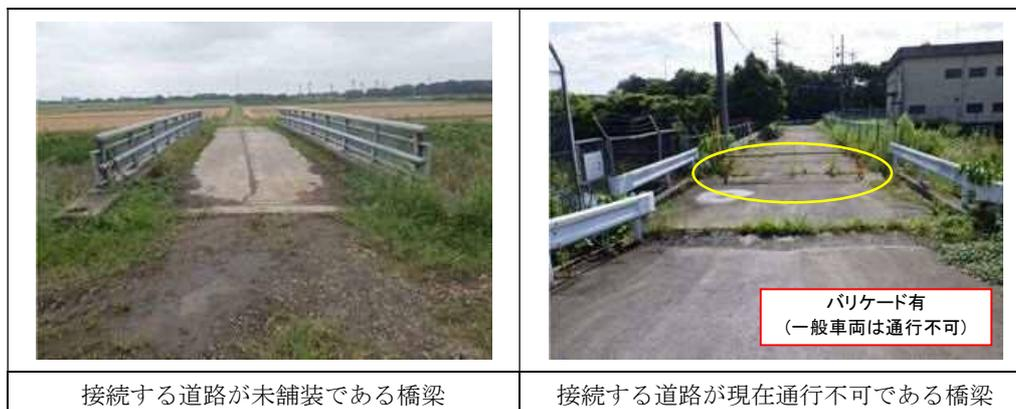
図 5.3 集約化・撤去の検討対象橋梁の一例
