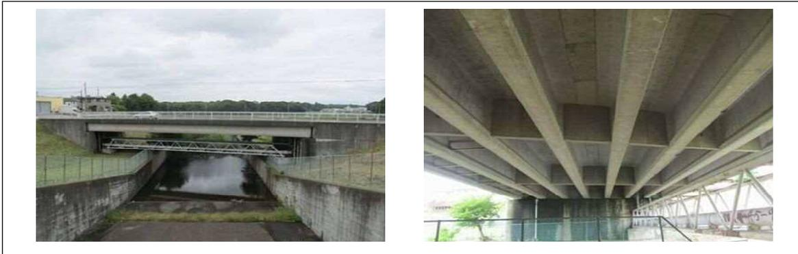
**RC橋**：西荻久保橋（2径間連続RC中空床版橋、橋長 40.3m）
