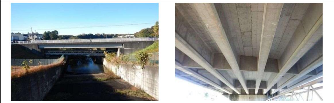
**RC橋**：北守谷橋（上り線）（2径間連続RC中空床版橋、橋長 40.5m）
