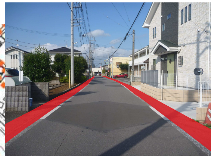
カラー舗装施工イメージ
