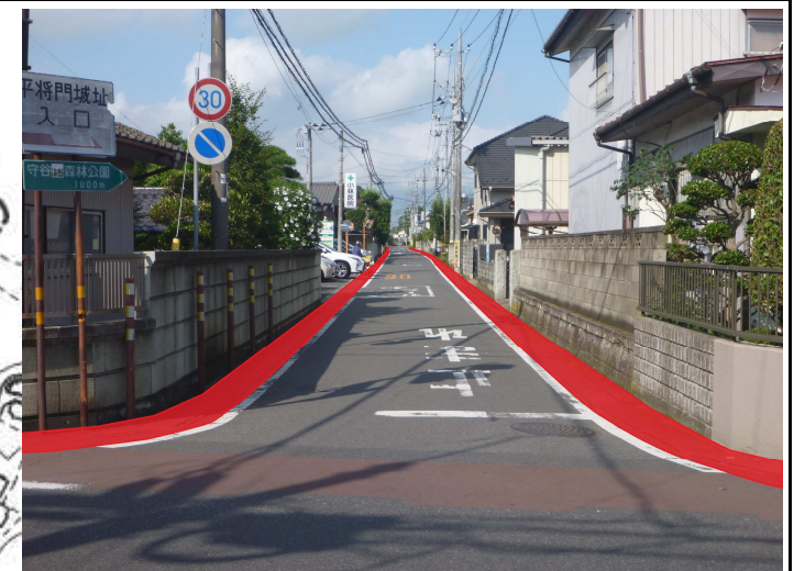
カラー舗装施工イメージ
