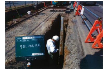
汚水管撤去状況
