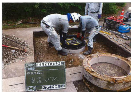
人孔鉄蓋更新工事
