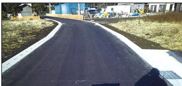
【施工例】 拡幅改良が完了した市道3154号線(本町地内)
