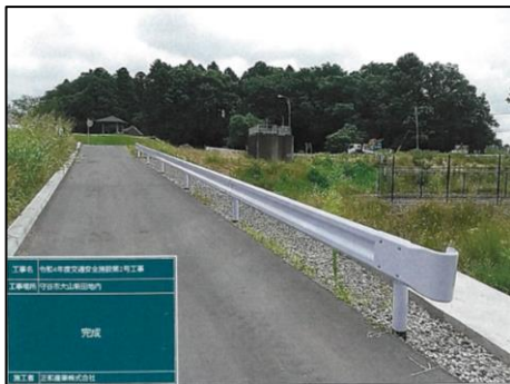
【施工例】 ガードレール設置(大山新田地内)
