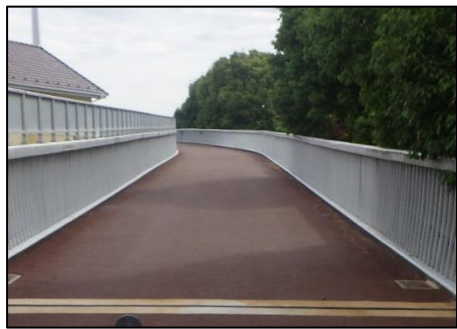
【施工例】 橋面の修繕工事が完了した歩道橋(山王歩道橋)
