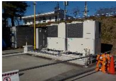
屋内運動場空調設備設置工事(左:GHP、右:室内機)
