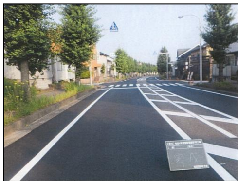
【施工例】 舗装工事が完了した市道101号線(松ヶ丘地内)
