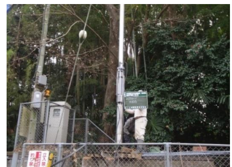
ポンプ更新工事
