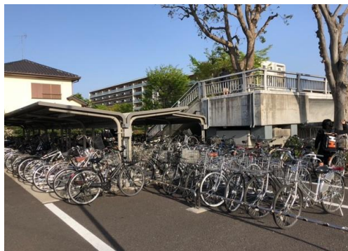
新守谷自転車駐車場
