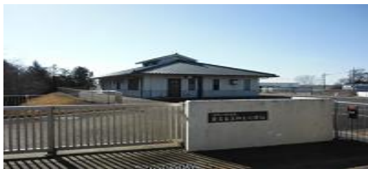
西板戸井地区 農業集落排水処理場
