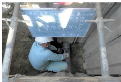
汚水樹設置工事
