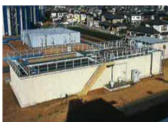
撤去予定浄水施設
