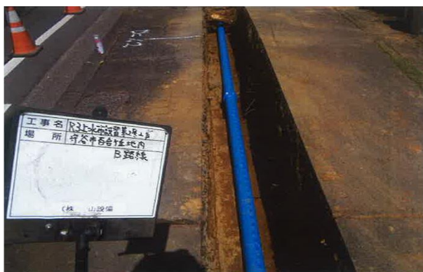
配水管布設替工事
