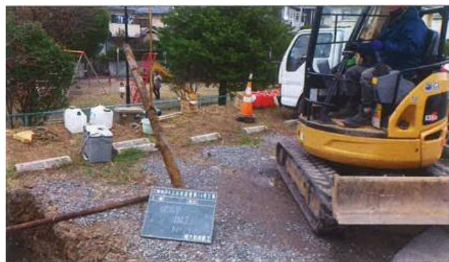
老朽管撤去状況
