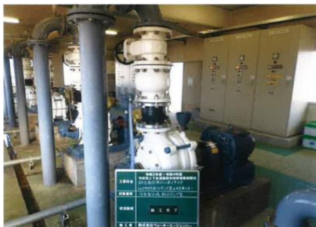
No.5守谷系配水ポンプ逆止弁交換工事
