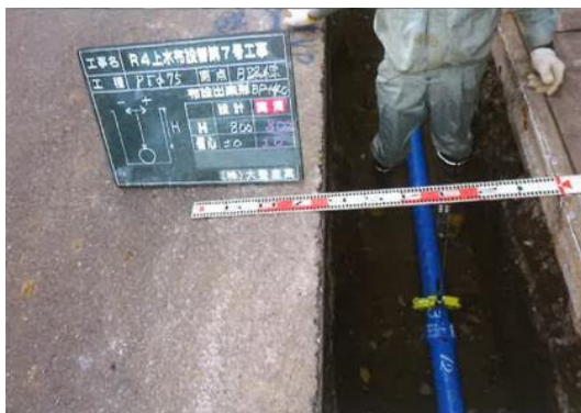
布設替工事(老朽管更新)状況
