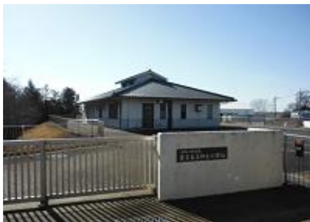
西板戸井地区 農業集落排水処理場
