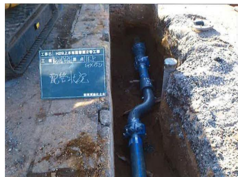
配水管布設替工事
