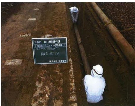
既設管撤去状況
