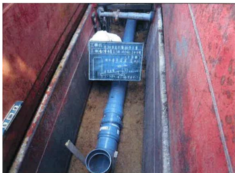
污水管布設工事
