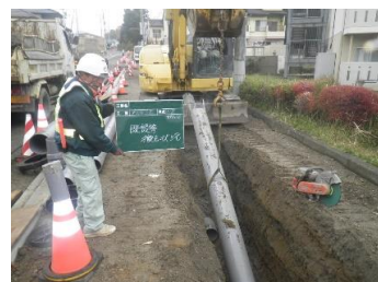
汚水管撤去状況
