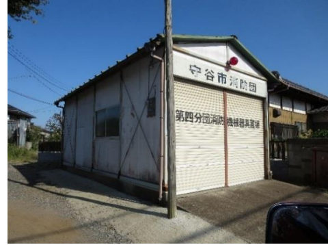
老朽化している機械器具置場
