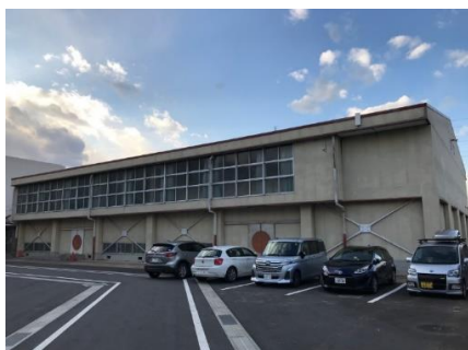
屋内運動場全景
