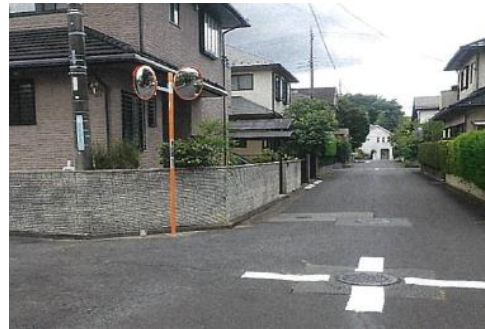
カーブミラー設置
