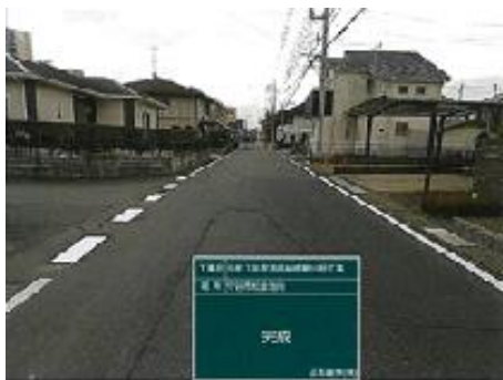
区画線の設置(松並地区)
