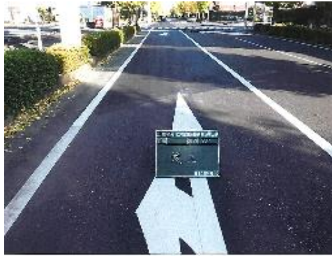
舗装工事が完了した市道101号線(松前台地内)
