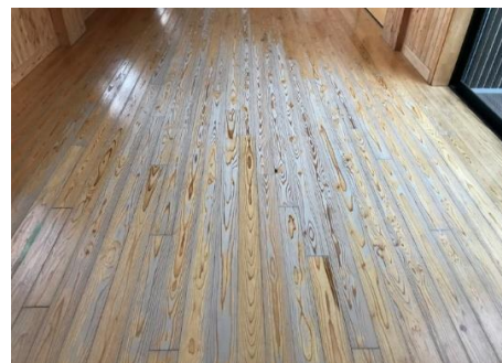
廊下内の床の状況
