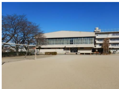
屋内運動場全景
