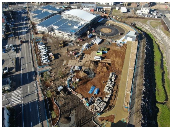
整備中の守谷駅東口市有地
