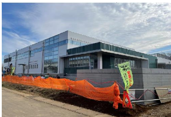
新給食センター(正面外構工事)
