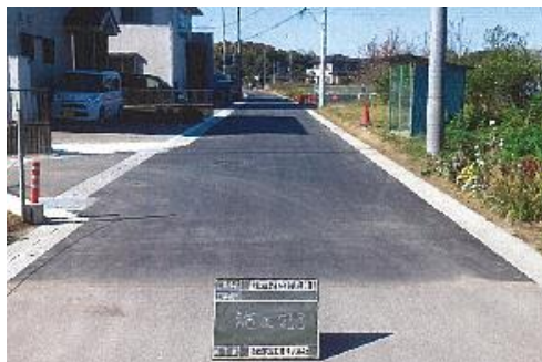
拡幅改良が完了した市道3159号線(本町地内)
