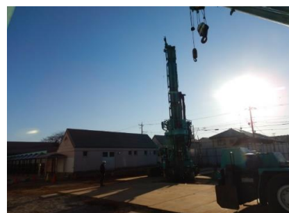
増築校舎基礎杭打設
