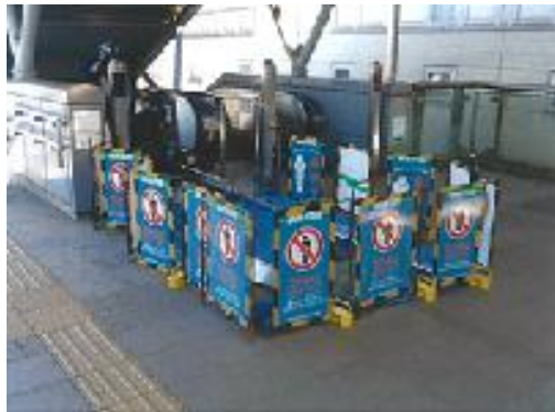
エスカレーター修繕工事 (土塔口)
