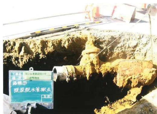
上水新設工事(老朽管撤去)状況
