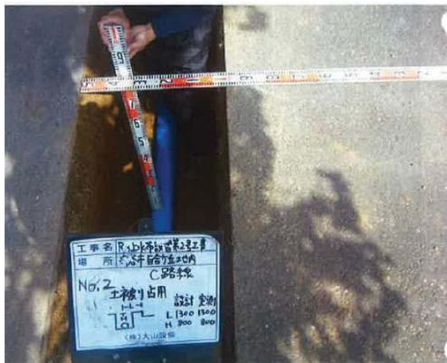
布設替工事(老朽管更新)状況
