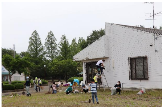
「みずき野ひろば」改修作業
