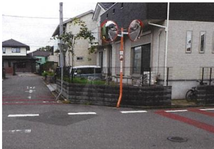
カーブミラー設置
