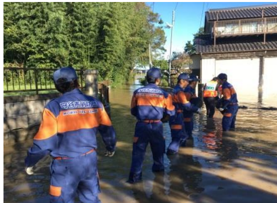
令和元年10月台風19号で鬼怒川の越水による 大山新田地区内での土のう積み作業
