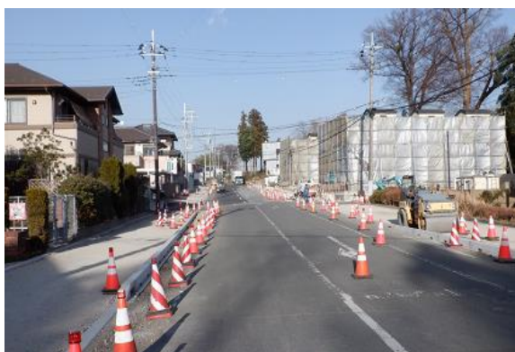
工事施工状況
