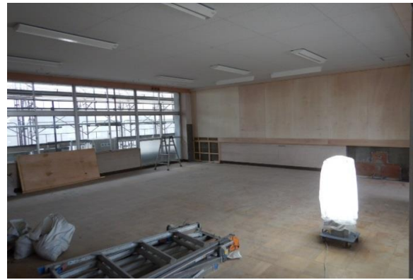
普通教室改修工事
