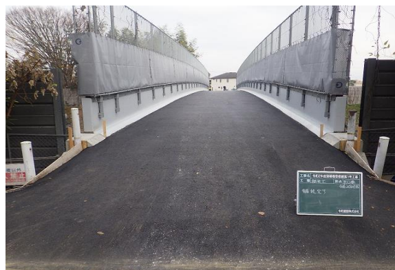
補修が完了した野口橋(上部)
