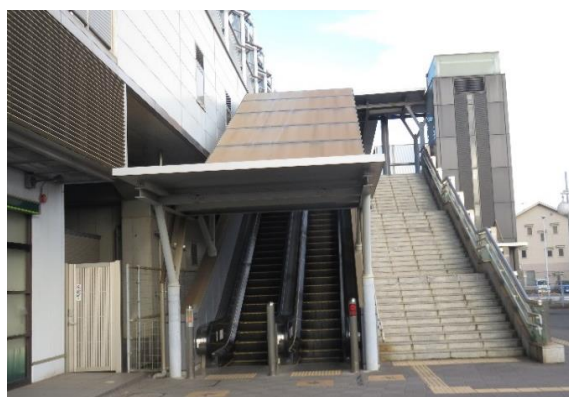
守谷駅土塔口エレベーター、エスカレーター
