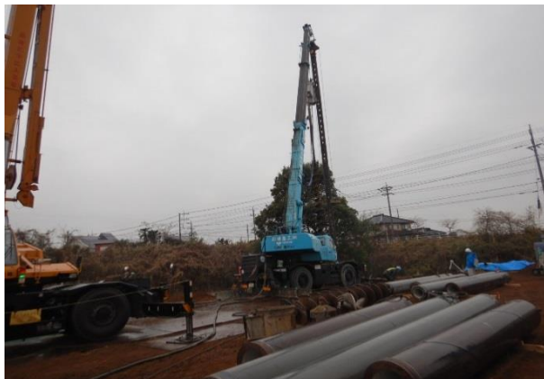
増築工事(試験杭打ち)
