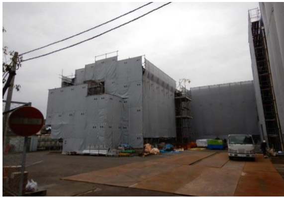
外壁補修工事
