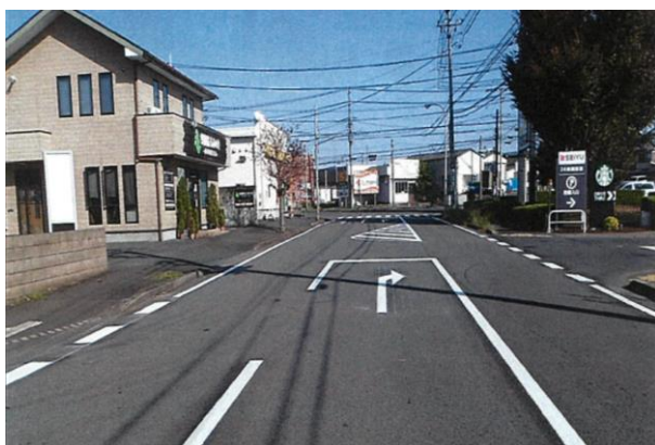
区画線設置(けやき台地内)
