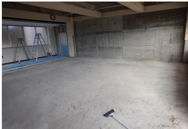
改修工事(旧資料室→新保健室)
