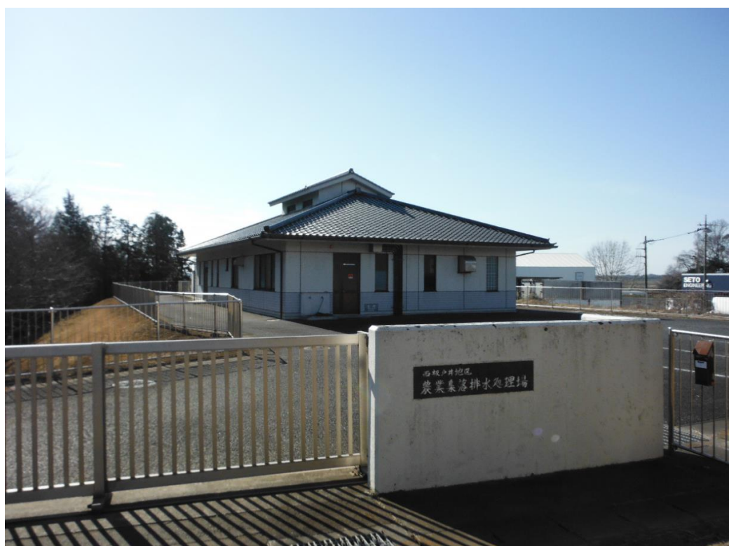
西板戸井地区 農業集落排水処理場
