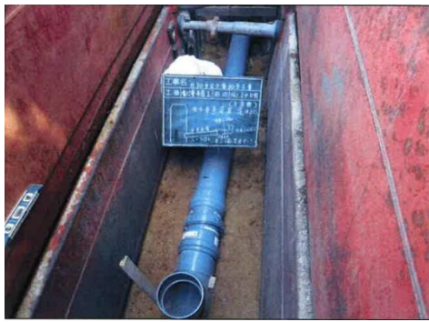
汚水管布設工事
