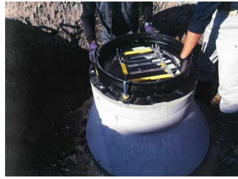
人孔鉄蓋更新工事
