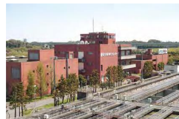
守谷浄化センター
