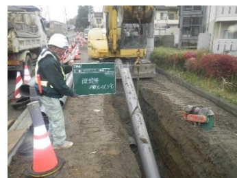
汚水管撤去状況
