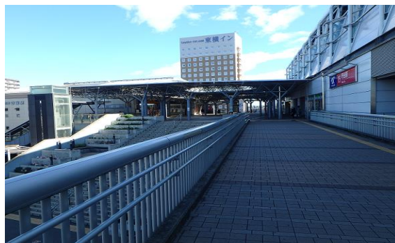
守谷駅自由通路
