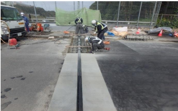
西荻久保橋の補修作業状況
