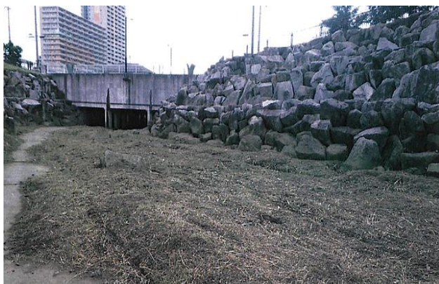
除草が完了したプロムナード水路
