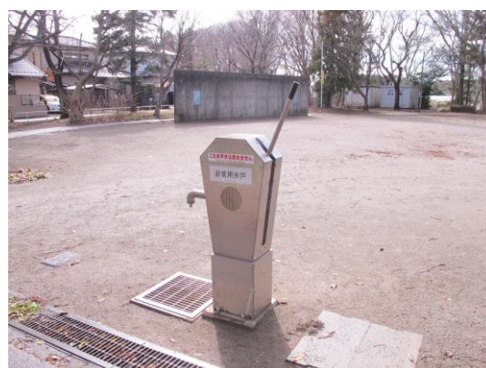
非常用防災井戸
