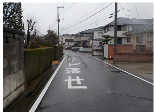
路面標示「スピード落せ」
