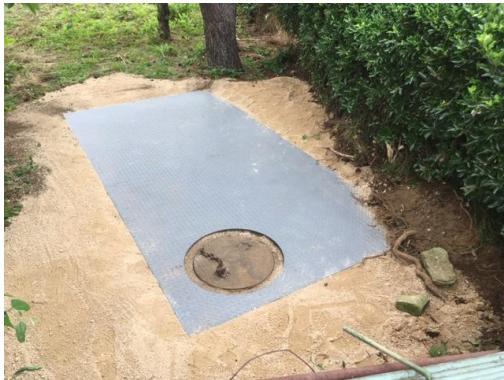
防火水槽(修繕)
