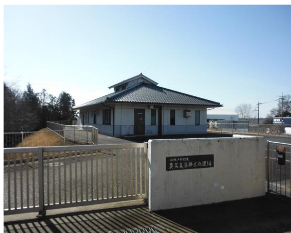
西板戸井地区 農業集落排水処理場
