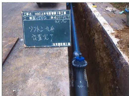
布設替工事(石綿管更新)状況
