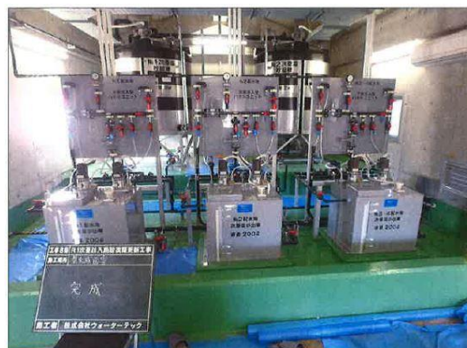
次亜注入設備更新工事状況
