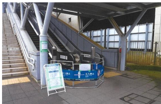
守谷駅自由通路エスカレーター修繕工事 (施工中)
