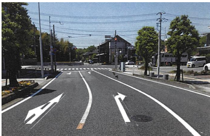
区画線設置(守谷交番前)
