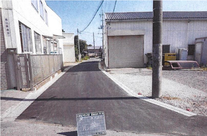
市道3104号線 側溝敷設・舗装
