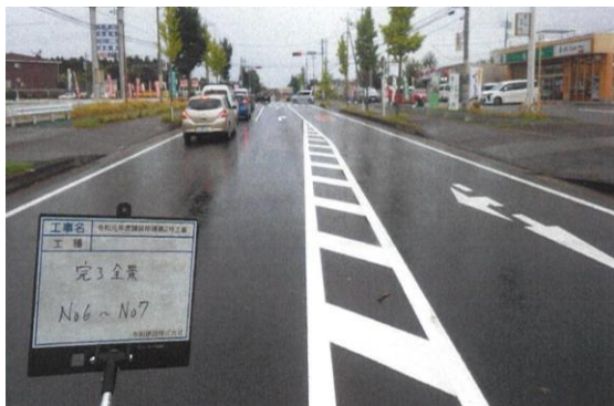
市道101号線(ふれあい道路)舗装修繕(美園)
