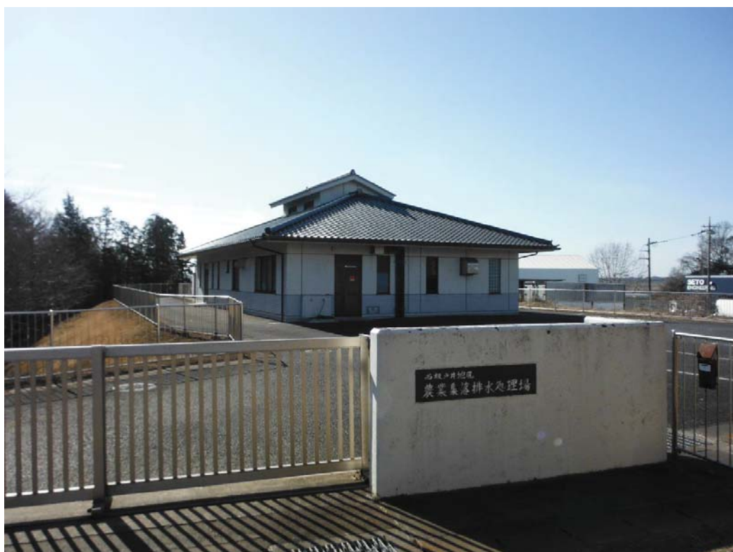
西板戸井地区 農業集落排水処理場
