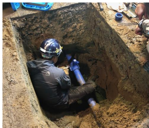
配水管布設替工事
